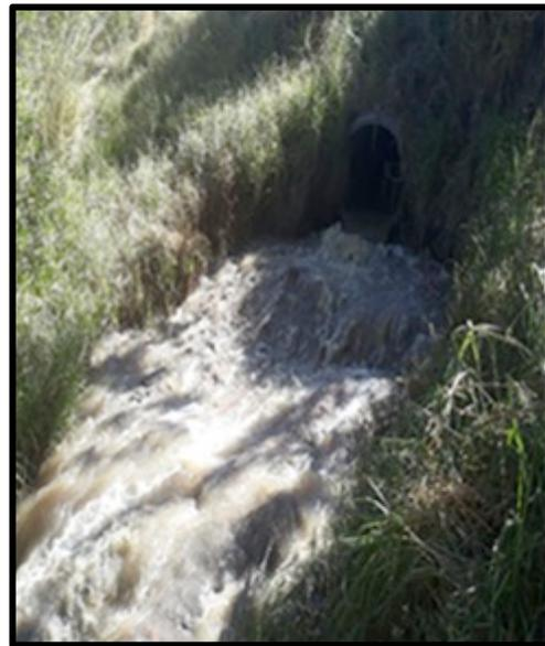
**Figura 7.** Descarga de aguas sin tratamiento de la PTAR del municipio de Tlaxco al río Zahuapan.
