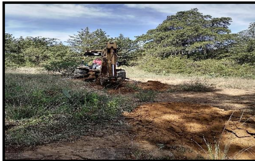
Figura 2. Construcción de la obra de conservación zanja bordo.
